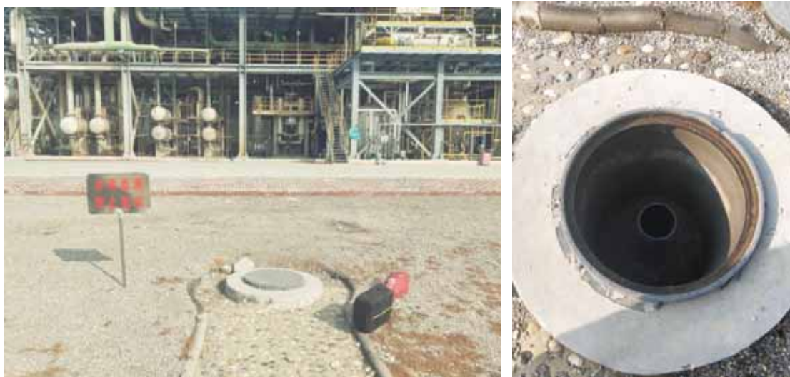
图 5.3-17 厂区施工的污染监控井
