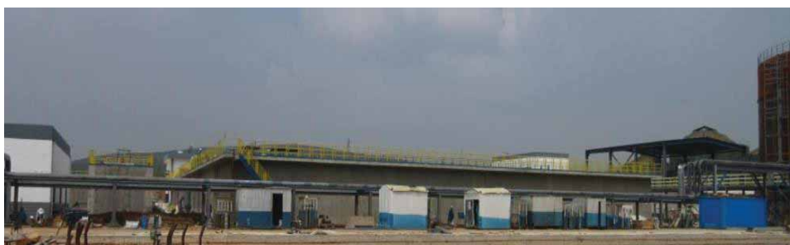
生化池（A池+O1池+O2池）
